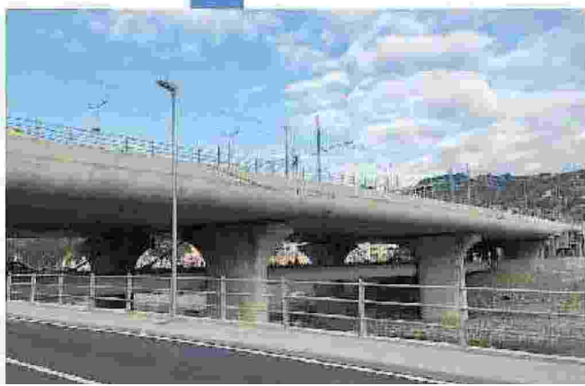
Collegamenti Viadotto, ponte e l'area della nuova stazione a Imperia
